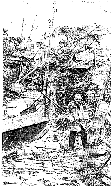
建設労働者の不足から、倒壊家屋の整理は思うように進んでいない—神戸市東灘区で3日
